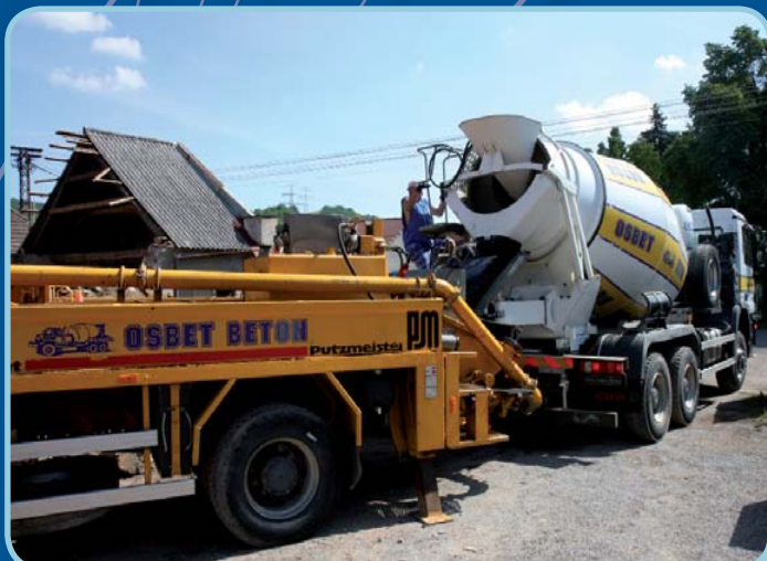
Čerpání betonu
