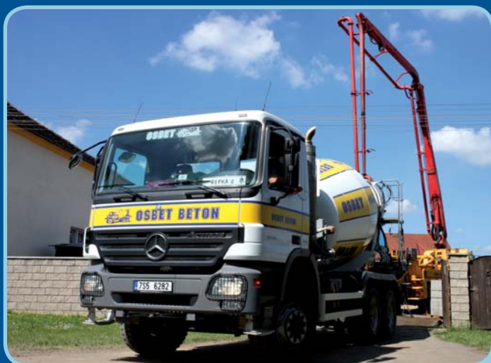
Příjezd mixu a čerpadla na stavbu
