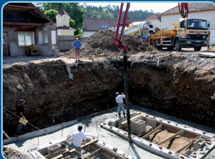
Betonování základů stavby
