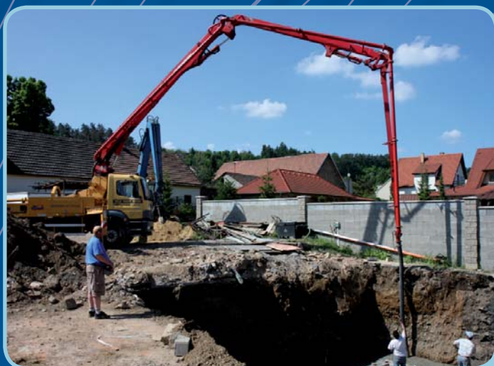
Uložení betonu do základů stavby
