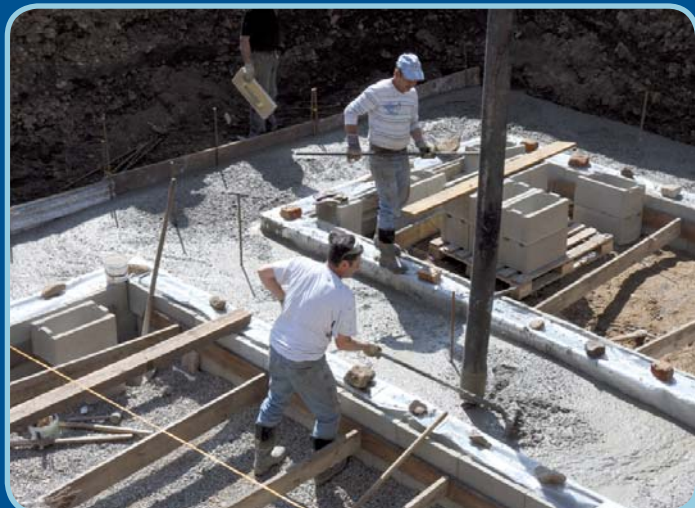
Betonování základů stavby
