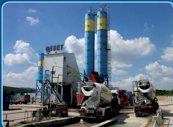
Technologické zázemí betonárny
