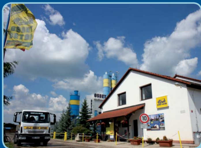
Administrativní budova Osbet beton, s.r.o., Lety u Dobřichovic
